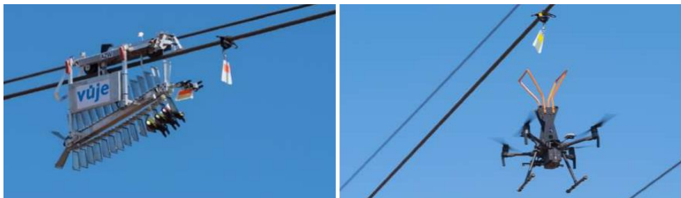
Slika 9. Robot za postavljanje markera-levo i dron za postavljanje markera-desno
